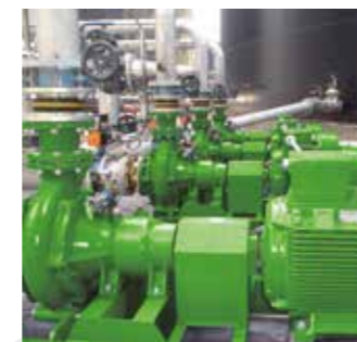
MAGNUM SX Dickstoffpumpe Getriebe- und Lagerstuhlausführung
